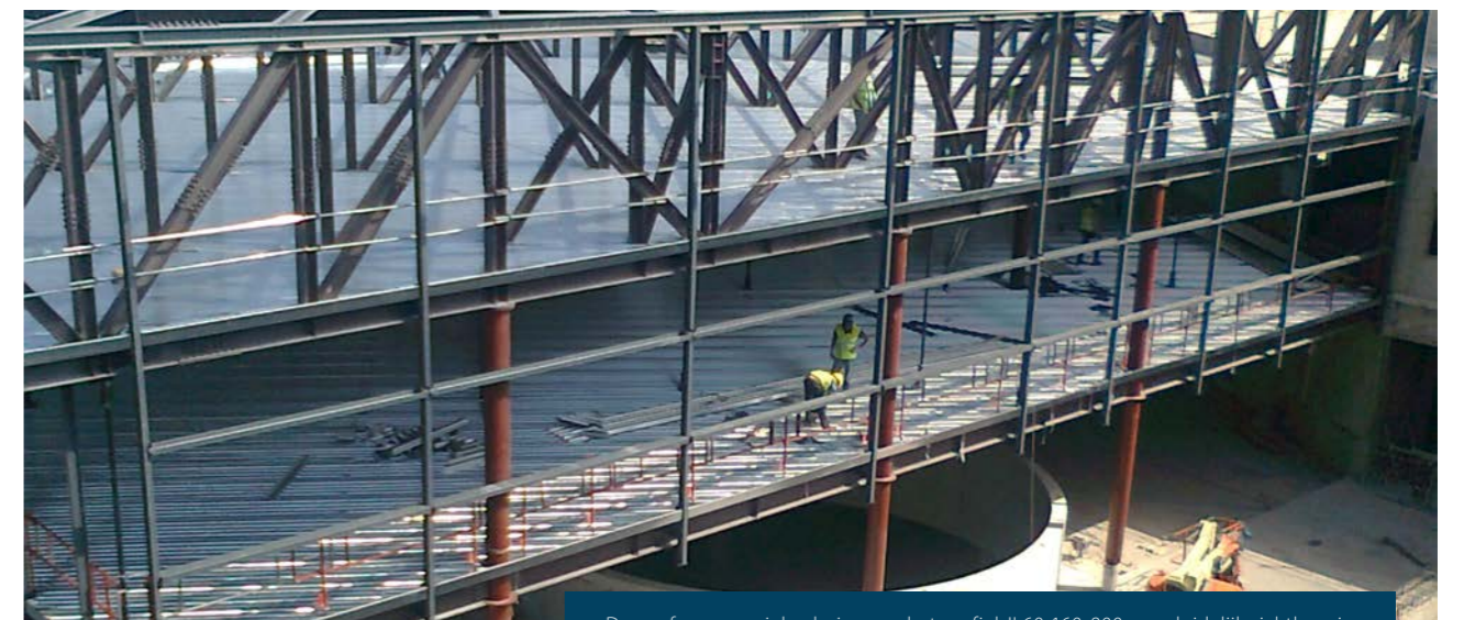
De werf van een ziekenhuis, waar het profiel JI 60-160-800 nog duidelijk zichtbaar is.
