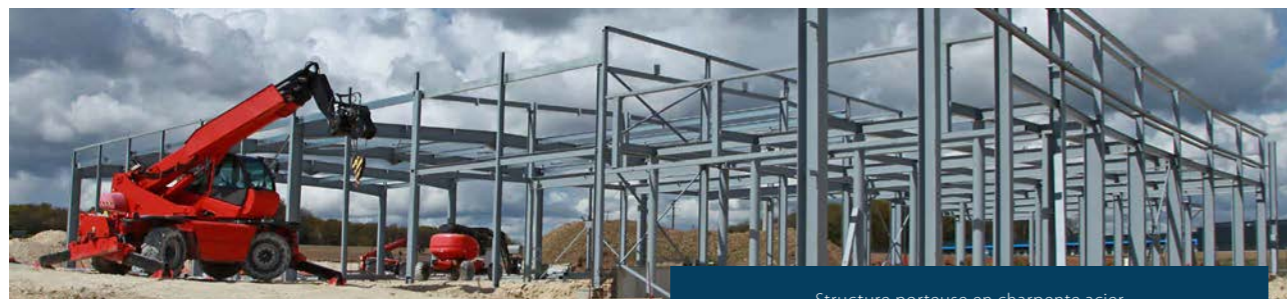
Structure porteuse en charpente acier
