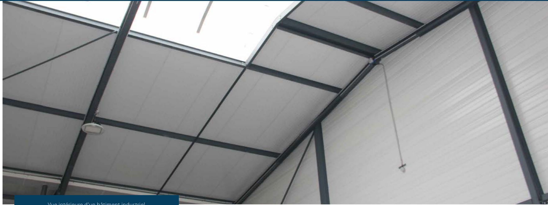
Vue intérieure d'un bâtiment industriel
