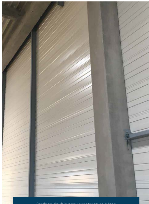
Bardage double peau sur structure béton
