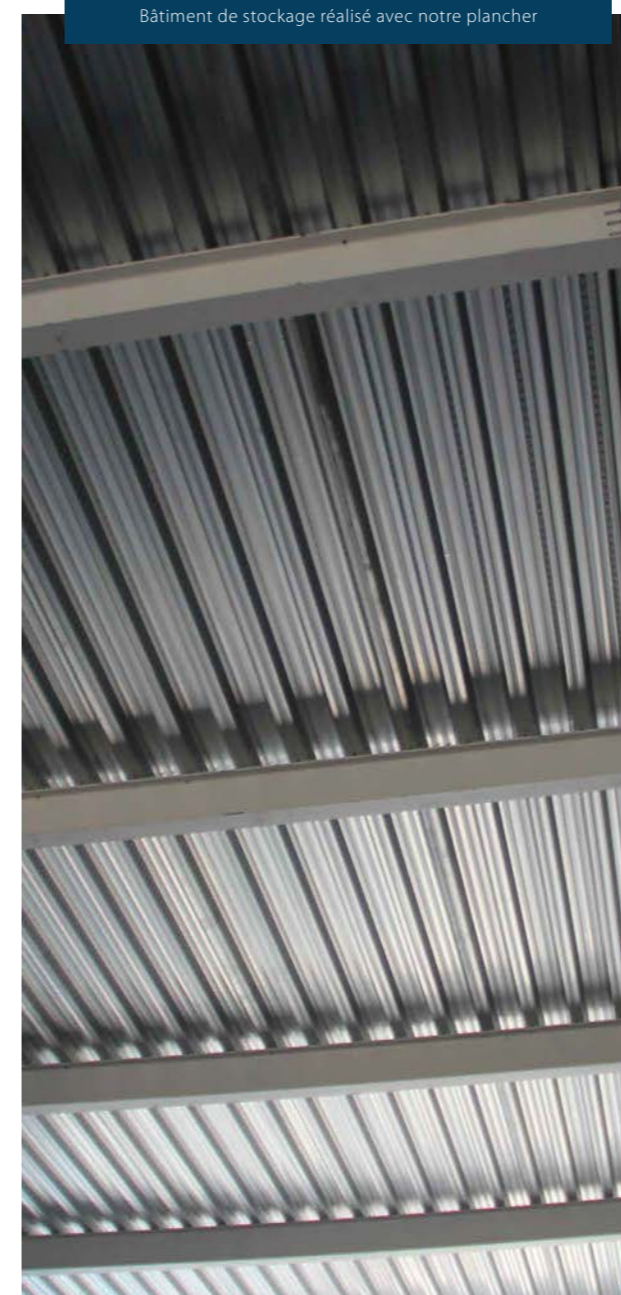
Bâtiment de stockage réalisé avec notre plancher
