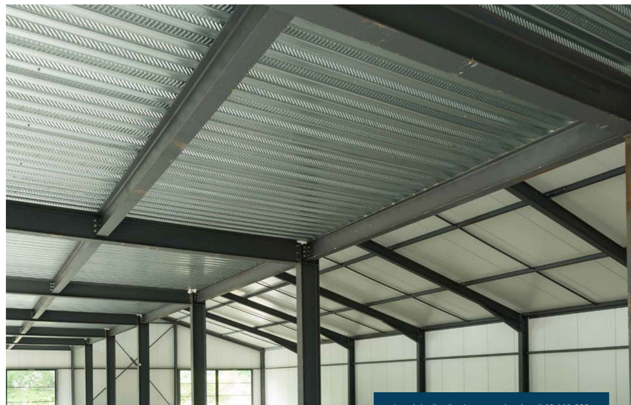
Local de distribution avec plancher JI 60-160-800
