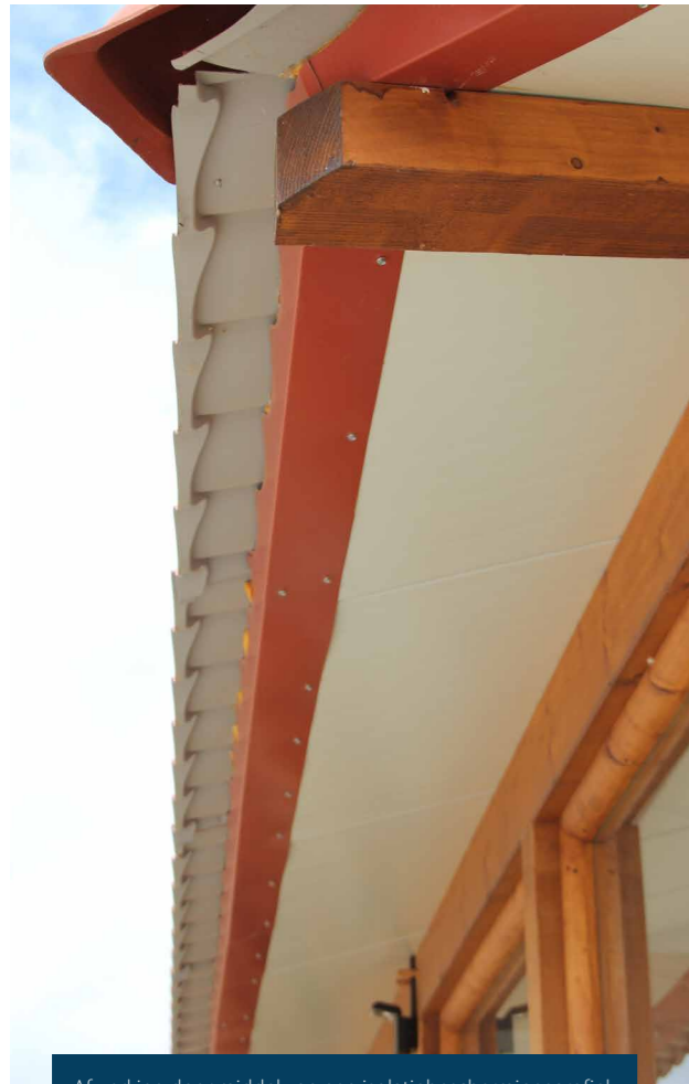
Afwerking door middel van een isolatiebeschermingsprofiel.
