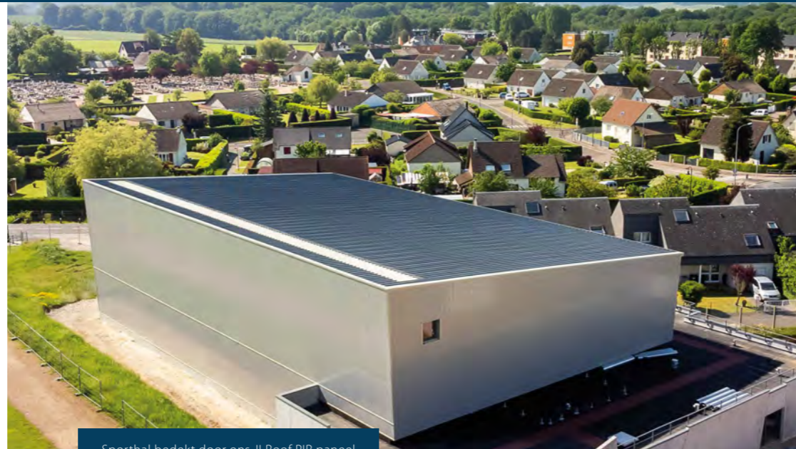
Sporthal bedekt door ons JI Roof PIR paneel
