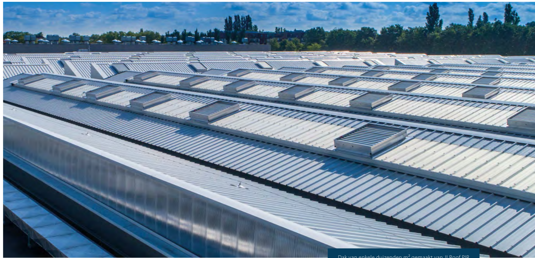
Dak van enkele duizenden m 2 gemaakt van JI Roof PIR
