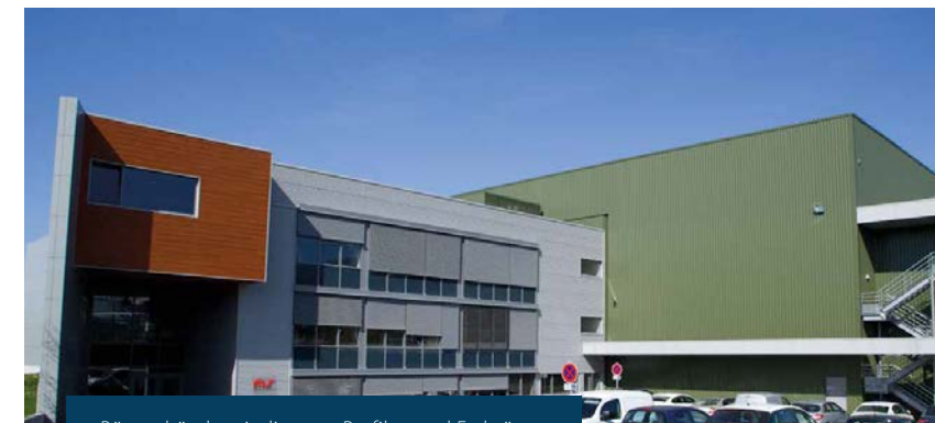
Bürogebäude mit diversen Profilen und Farbtönen
