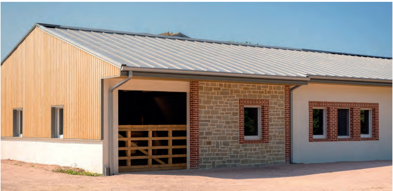
Dakbedekking met staande naad - RAL 7042.
