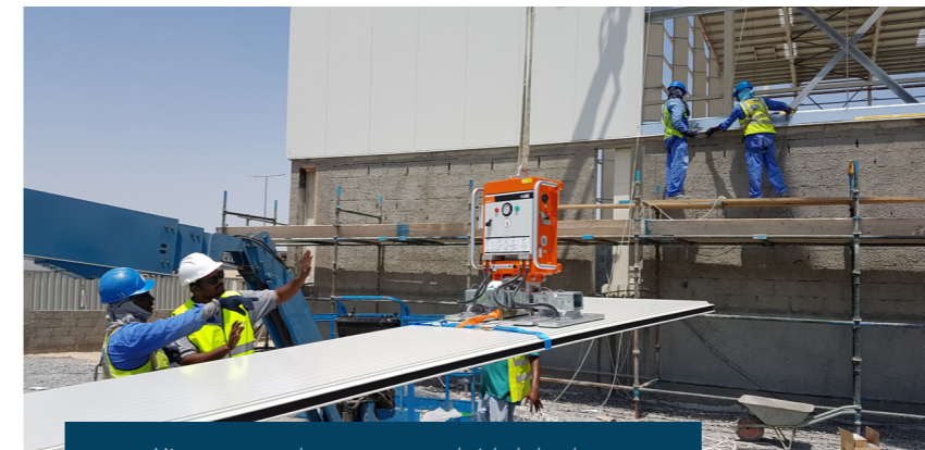
Mise en œuvre des panneaux sandwich de bardage.
