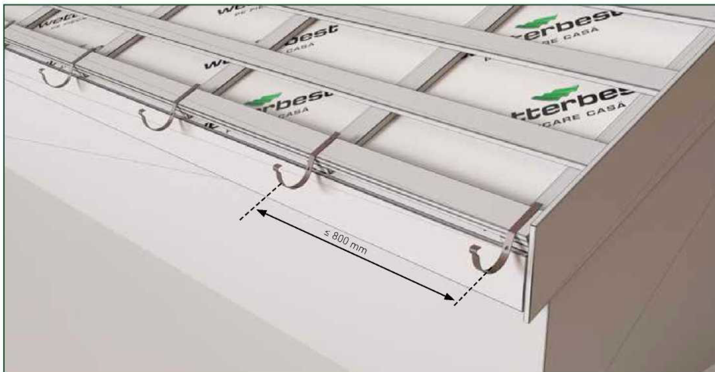
Монтаж на куки за стрехи
