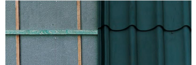
Renovierung auf Bitumenbahnen: Hier bietet sich die Dach-auf-Dach-Methode an.
