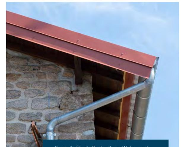
Kantenteile für die Dachseite im Wohnungsbau.
