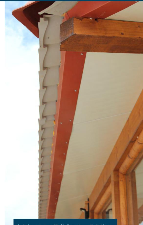
Isolationsschutzprofile für Paneele zur Abdichtung.
