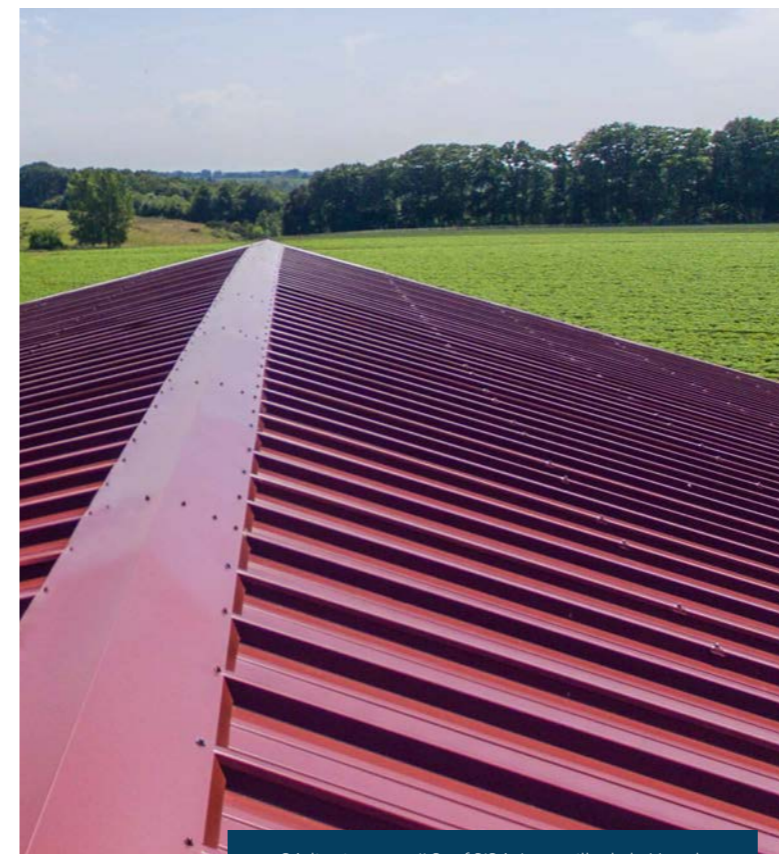
Réalisation avec JI Roof PIR à Angerville de la Martel.
