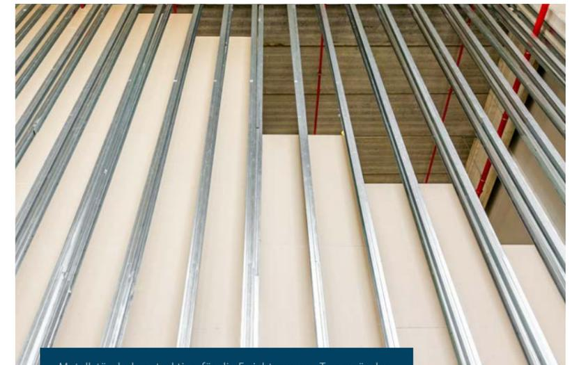
Metallständerkonstruktion für die Errichtung von Trennwänden.
