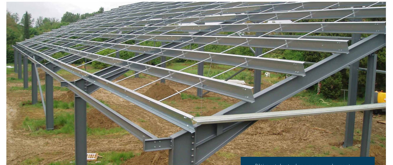
Bâtiment de stockage en cours de montage.
