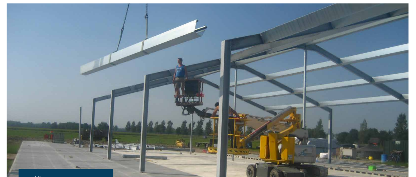
Mise en oeuvre en cours.
