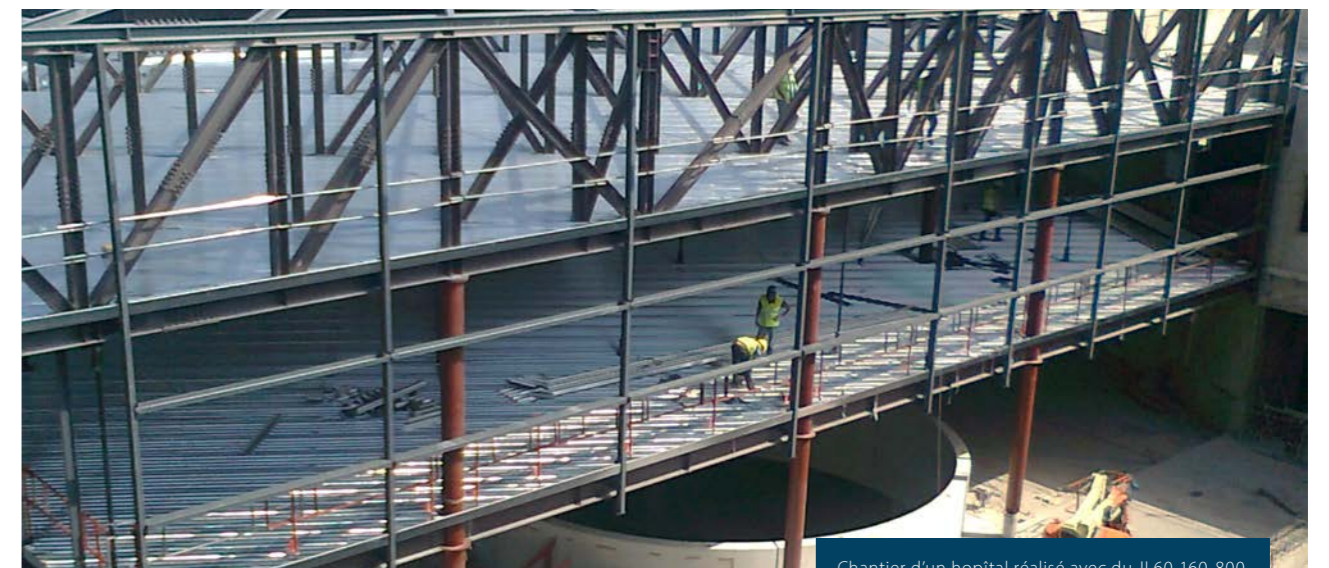
Chantier d'un hopital réalisé avec du Jl 60-160-800.
