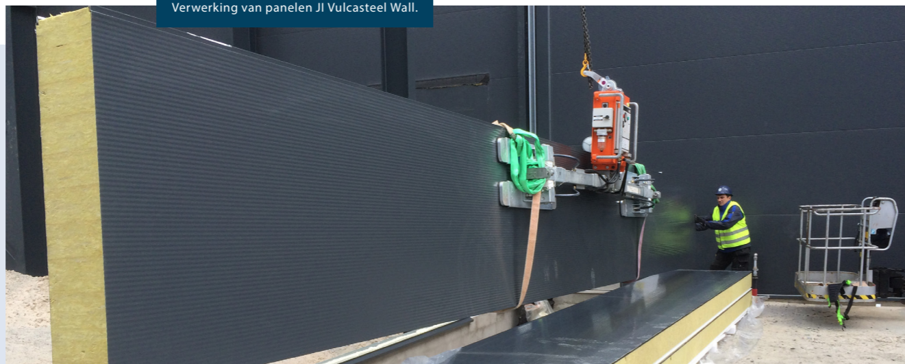
Verwerking van panelen JI Vulcasteel Wall.
