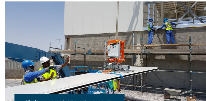
Plaatsing van sandwichpanelen op gevels.
