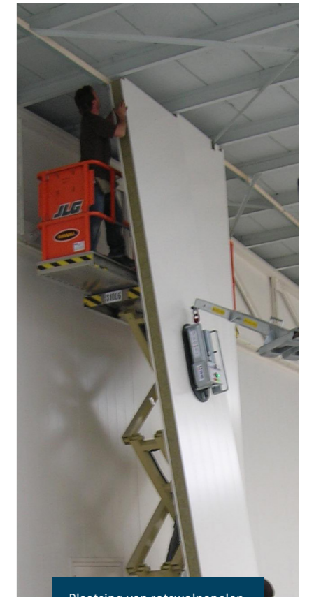
Plaatsing van rotswolpanelen.
