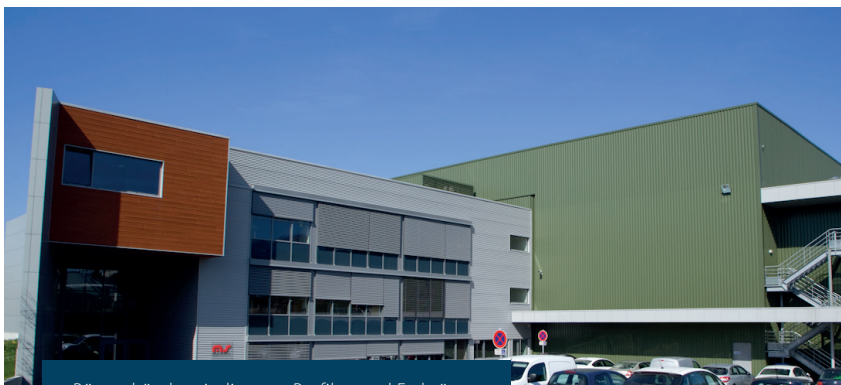
Bürogebäude mit diversen Profilen und Farbtönen
