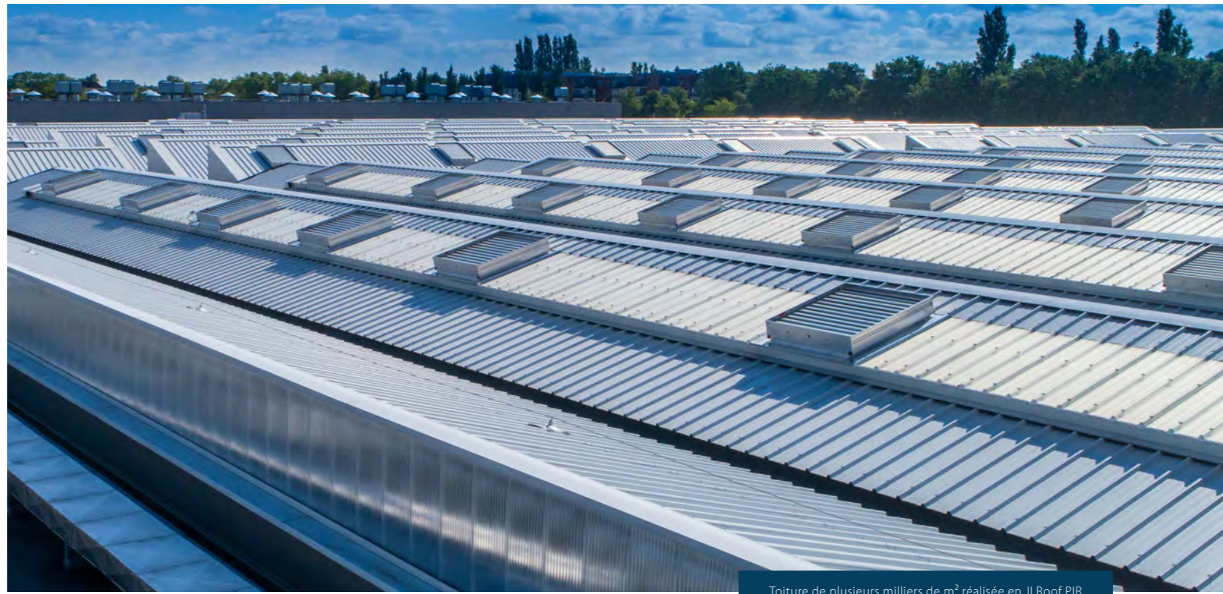
Toiture de plusieurs milliers de m 2 réalisée en JI Roof PIR
