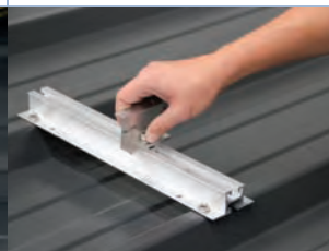
Op de bevestigingsvlakken een strook butylband (18 x 4 mm) aanbrengen
