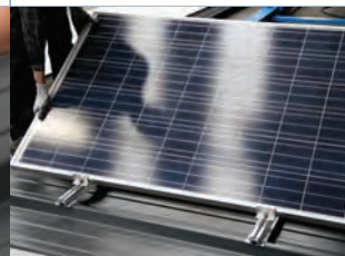
Op de bevestigingsvlakken een strook butylband (18 x 4 mm) aanbrengen
