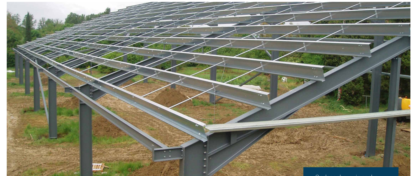
Opslaggebouw in aanbouw.
