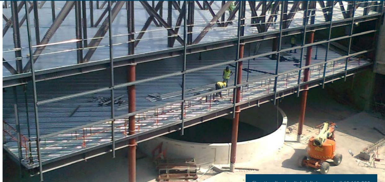
Chantier d'un hopital réalisé avec du JI 60-160-800.
