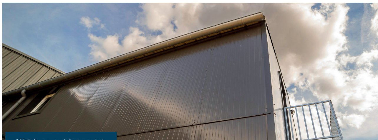
JI FT Wall pour une réalisation agricole.
