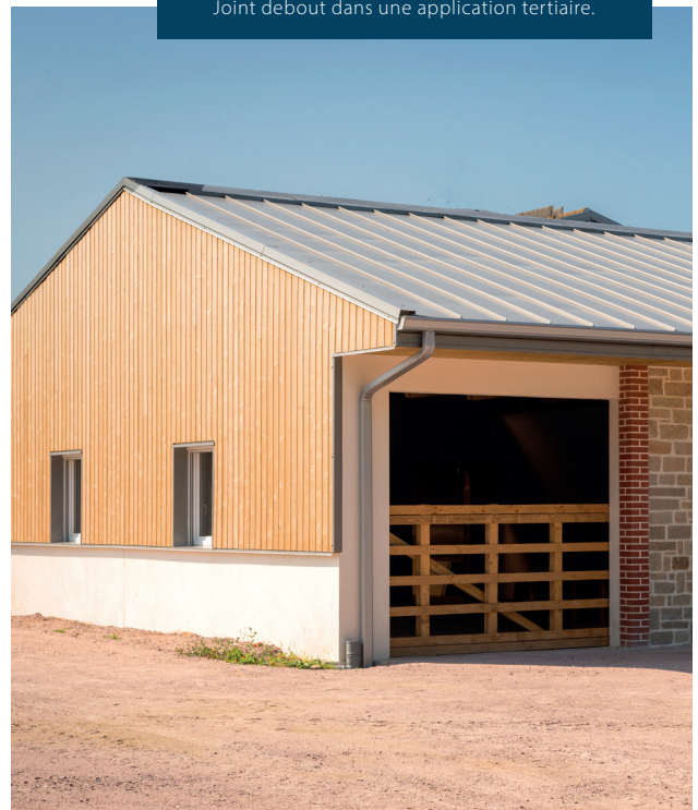
Joint debout dans une application tertiaire.
