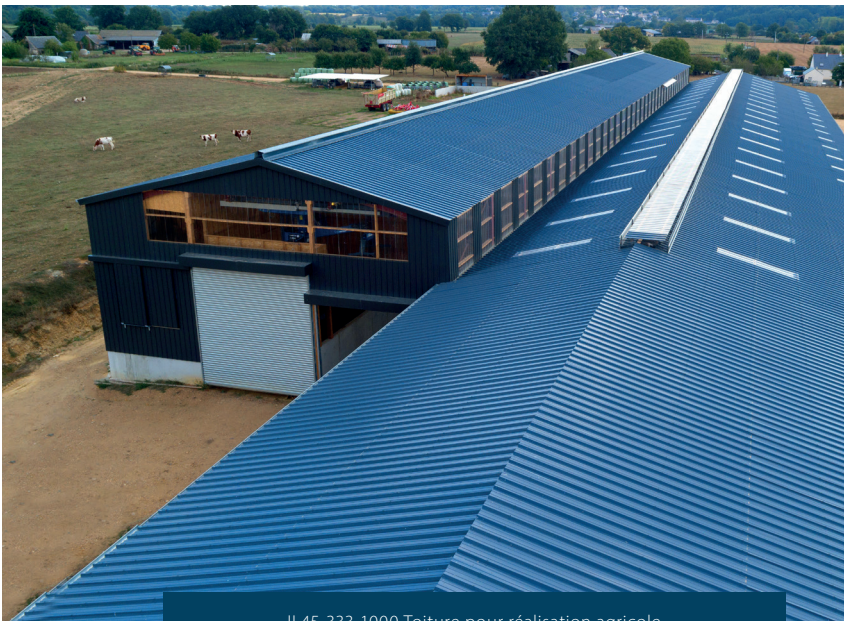
Ji 45-333-1000 Toiture pour réalisation agricole.
