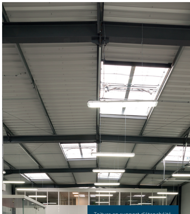
Toiture en support d'étanchéité.
