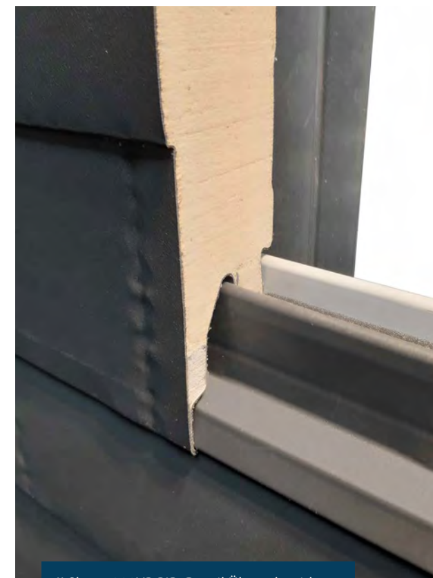
JI Slate 1000VB PIR, Detail Überschneidung.
