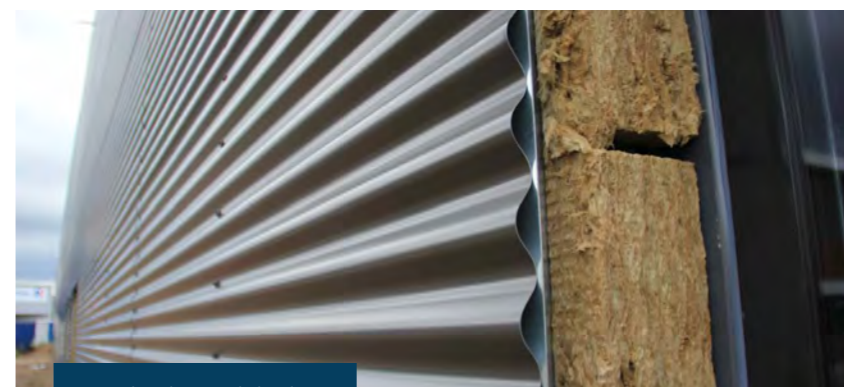
Pose des plateaux de bardage.
