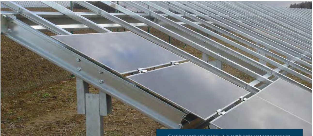
Gordingconstructie gebruikt in combinatie met zonnepanelen
