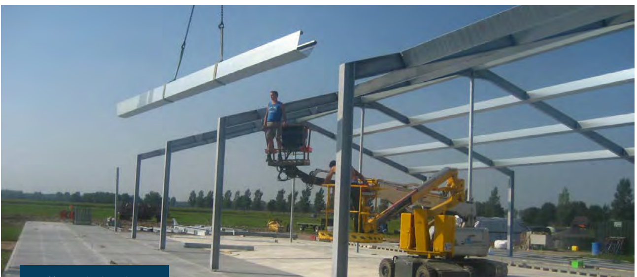
Montage in uitvoering.
