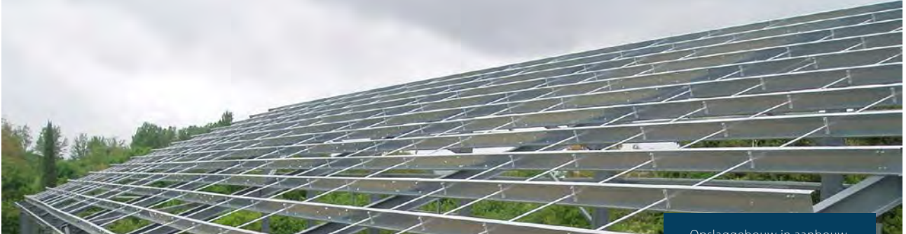
Opslaggebouw in aanbouw.
