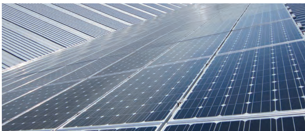
Zonnepanelen veilig gemonteerd op het JI 45-333-1000 Dak profiel.
