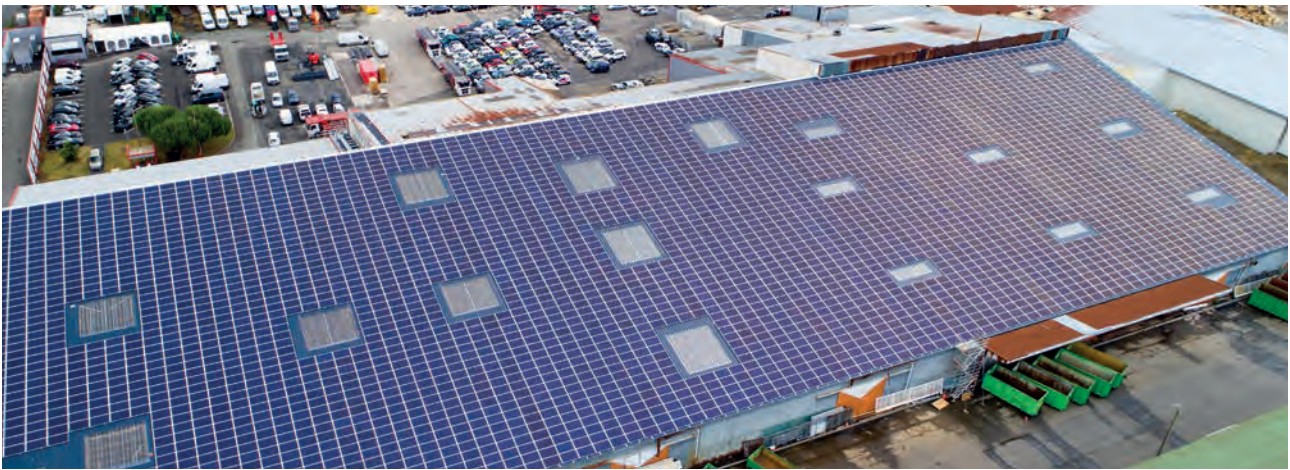
12 000 m 2 van JI 45-333-1000 met Opti'Roof voor een elektriciteitsproductie van 1 700 000 kWh (=600 woningen).
