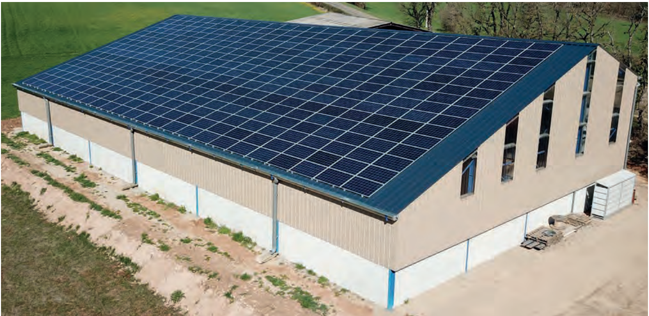
1000 m 2 gerealiseerd met ons Jorisolar Opti'Roof-systeem.
