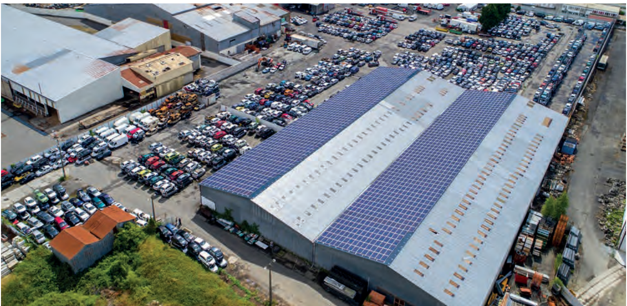
Tertiaire realisatie (160 meter lang op 50 meter breed).
