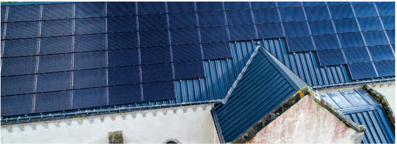
Realisatie met plaatsing op profiel JI 45-333-1000 Dak en Opti'Roof.
