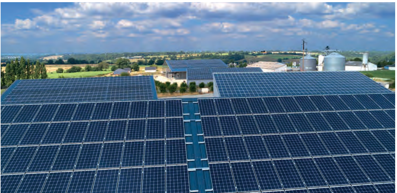
3000 m 2 dak uitgerust met Jorisolar RS-R en JI 45-333-1000.
