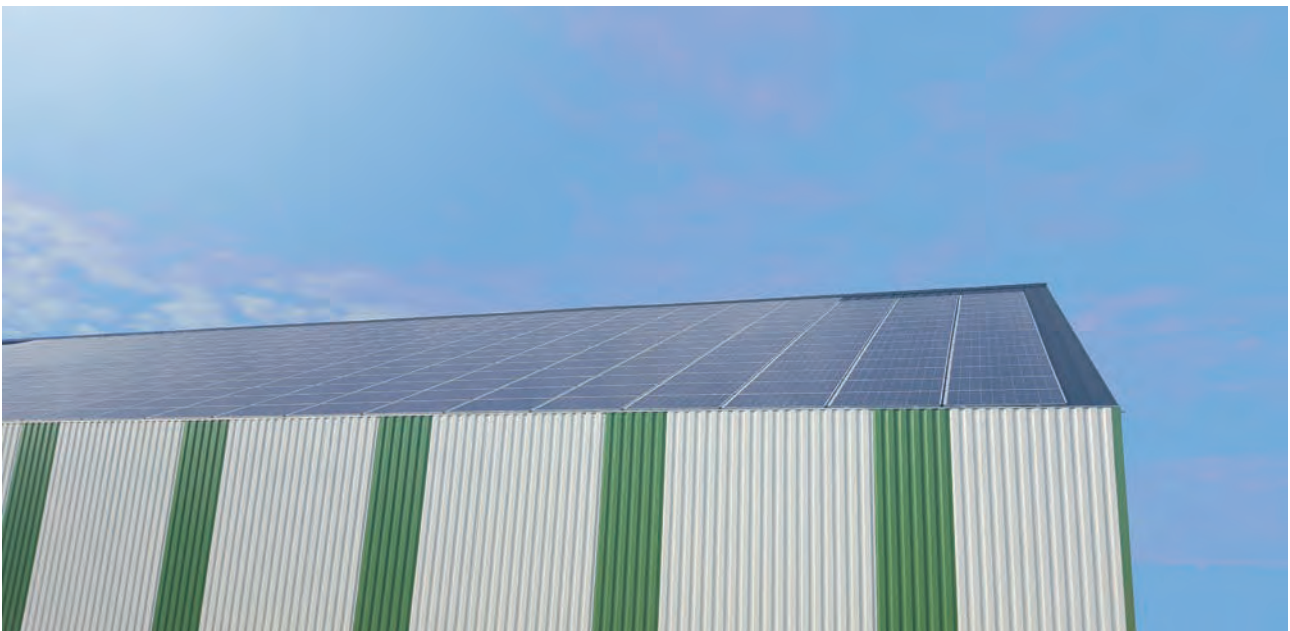
Dak volledig voorzien van fotovoltaïsche panelen.
