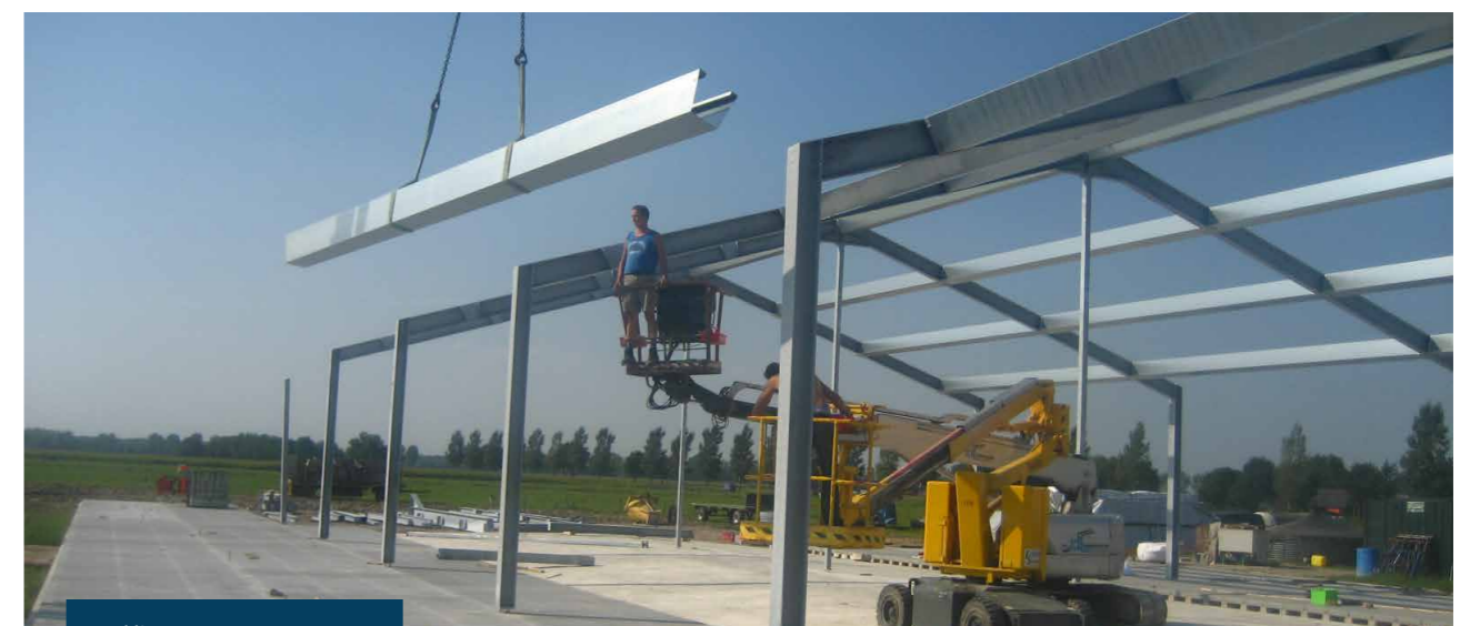
Mise en oeuvre en cours.
