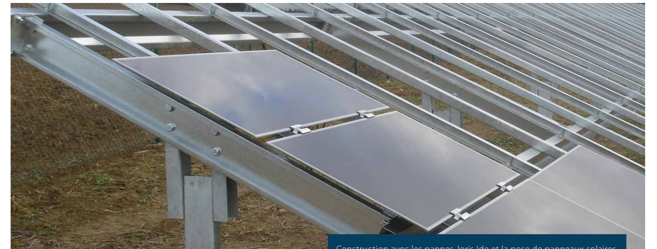
Construction avec les pannes Joris Ide et la pose de panneaux solaires.
