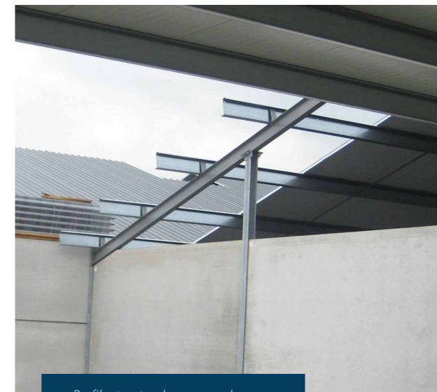
Profils structurels en cours de pose.
