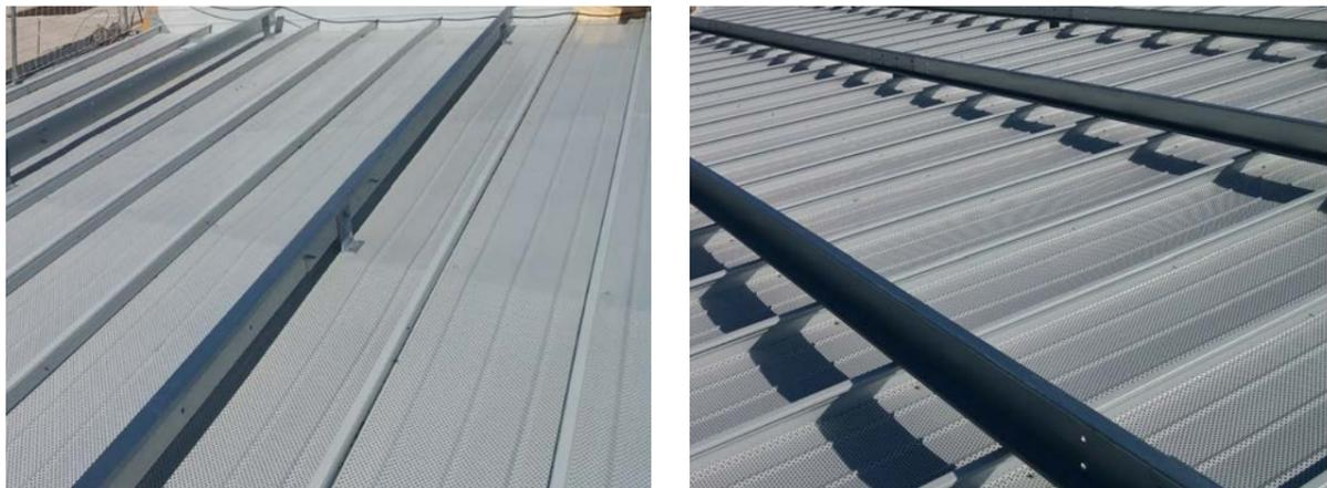
Les fausses pannes peuvent répondre aux prescriptions du § 5.3.1 du DTU 40.35 et se fixent par boulonnage sur les échantignoles préalablement posées. Ces échantignoles peuvent être également fixées par boulonnage, ou vissage dédié au-travers du plateau ou directement à la charpente; le plateau ayant été préalablement découpé. Nous consulter pour plus d'informations sur cette étape.
