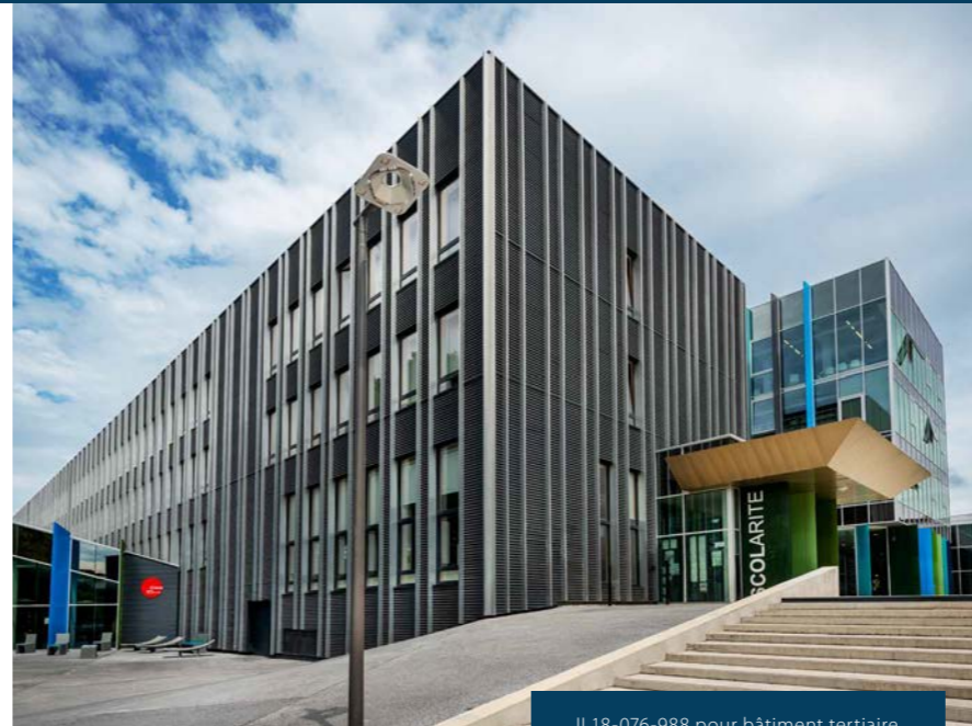
Jl 18-076-988 pour bâtiment tertiaire.
