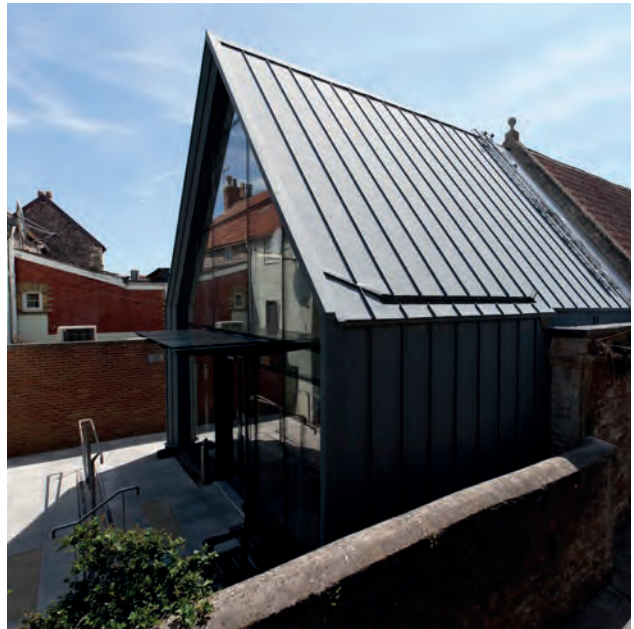
JI Vieo Edge 500 als dakbedekking voor een residentieel gebouw.
