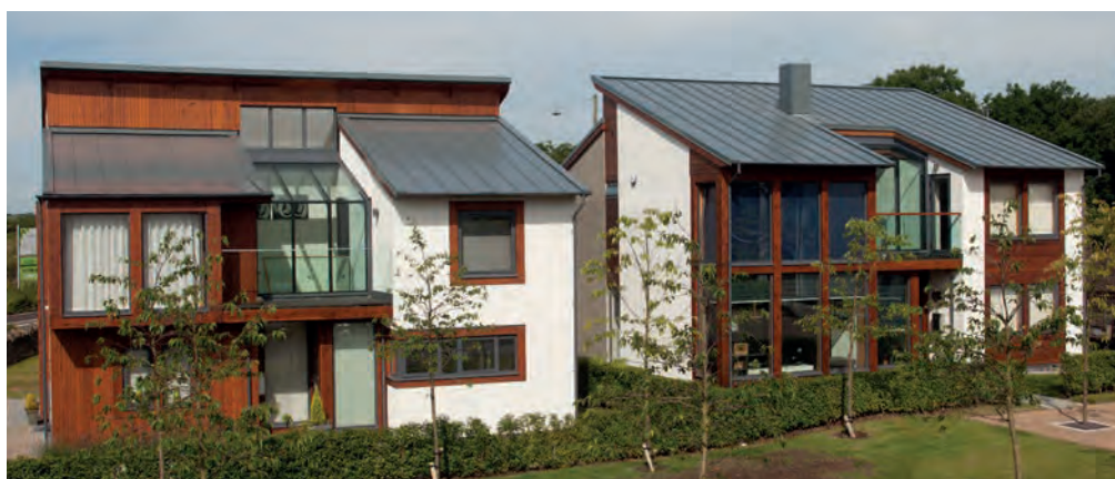
Residentiële project met het profiel als dakbedekking.
