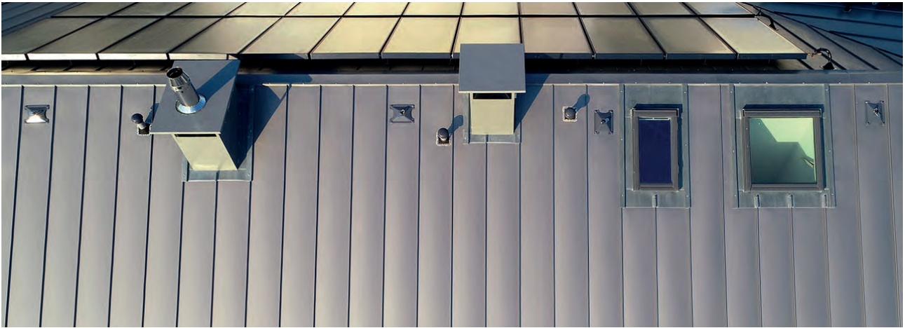
Jl Vieo Edge 500 als dakbedekking voor een residentieel gebouw.
