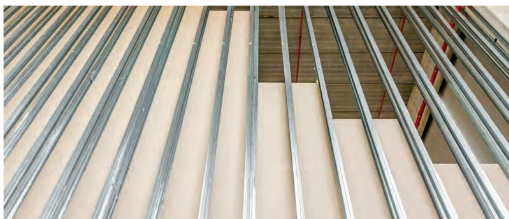
Mise en place des rails qui servent de support aux plaques de placoplâtre
