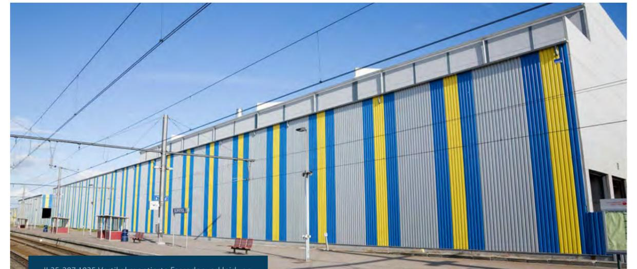
JI 35-207-1035 Vertikal montierte Fassadenverkleidung.
