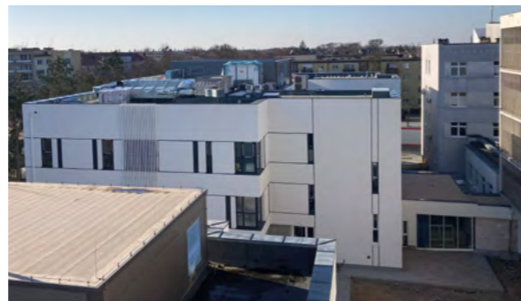
Stan budowy w 2022 r.
