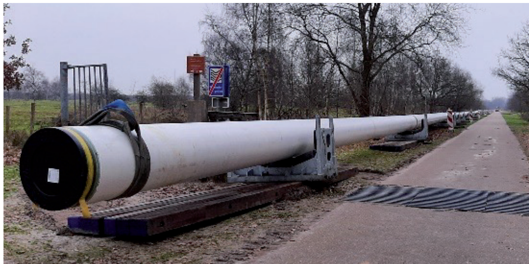
Figuur 5: Voorbeeld boorstreng 600mm buiten tracé open ontgraving. Met gebruik bestaande weg als rijbaan. (locatie: Burgh-Haamstede)
