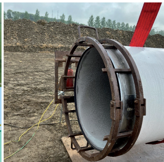
Figuur 2: Stalen waterleidingbuis met uitwendige kunststof coating en inwendige cementcoating.
