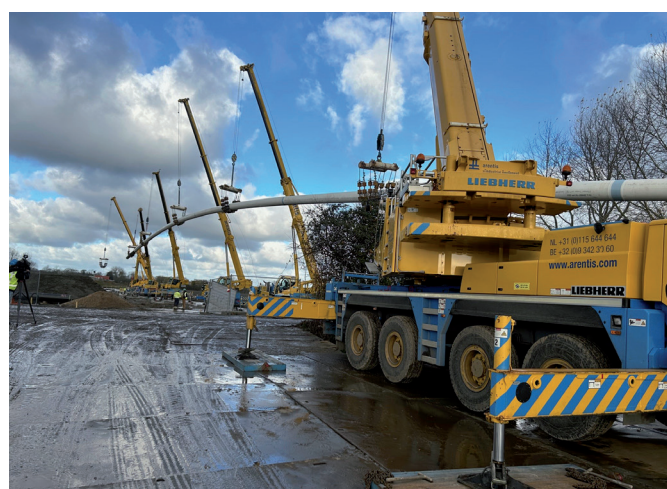
Figuur 6: Intrekoperatie met telekranen waarbij leiding in een boogstraal wordt gehouden (locatie: Evides project te Oost-Souburg)
